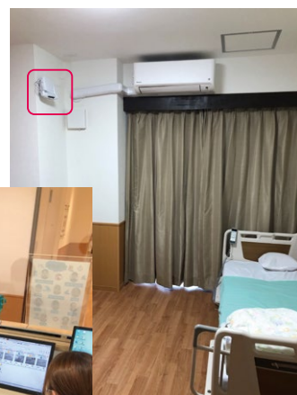
設置されている機器（左上）
